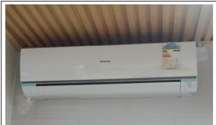
課室 AB 更換了 1 部兩匹一級能源標籤 R410A 掛牆分體冷氣機
