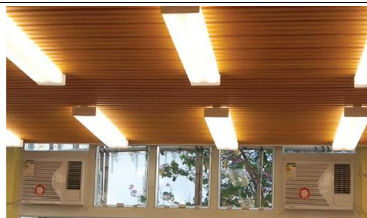
課室 I 更換了 2 部兩匹一級能源標籤 R410A 環保雪種窗口冷氣機
